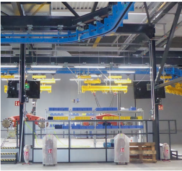
Am Maskierarbeitsplatz, der zusätzlich mit Großbildschirmen ausgestattet ist, können die nötigen Maskierungen aufgebracht werden.
