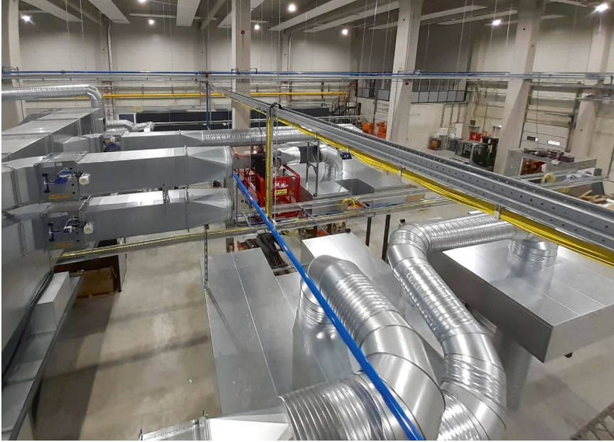
Anlagentechnik mit einem Frisch- und Abluftvolumenstrom von etwa 175.000 m 3 /h, der Gesamtumluftvolumenstrom inklusive aller Trockner liegt bei etwa 145.000 m 3 /h.
